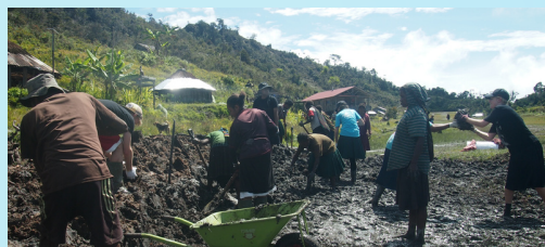
WORKING ON LENGTHENING THE AIRSTRIP BEKERJA UNTUK MEMPERPANJANG LANDASAN TERBANG
